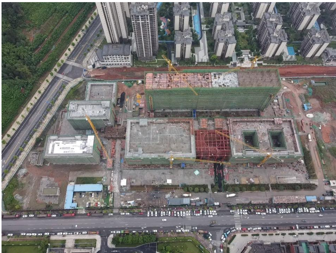
新院区建设现场航拍图（2）
