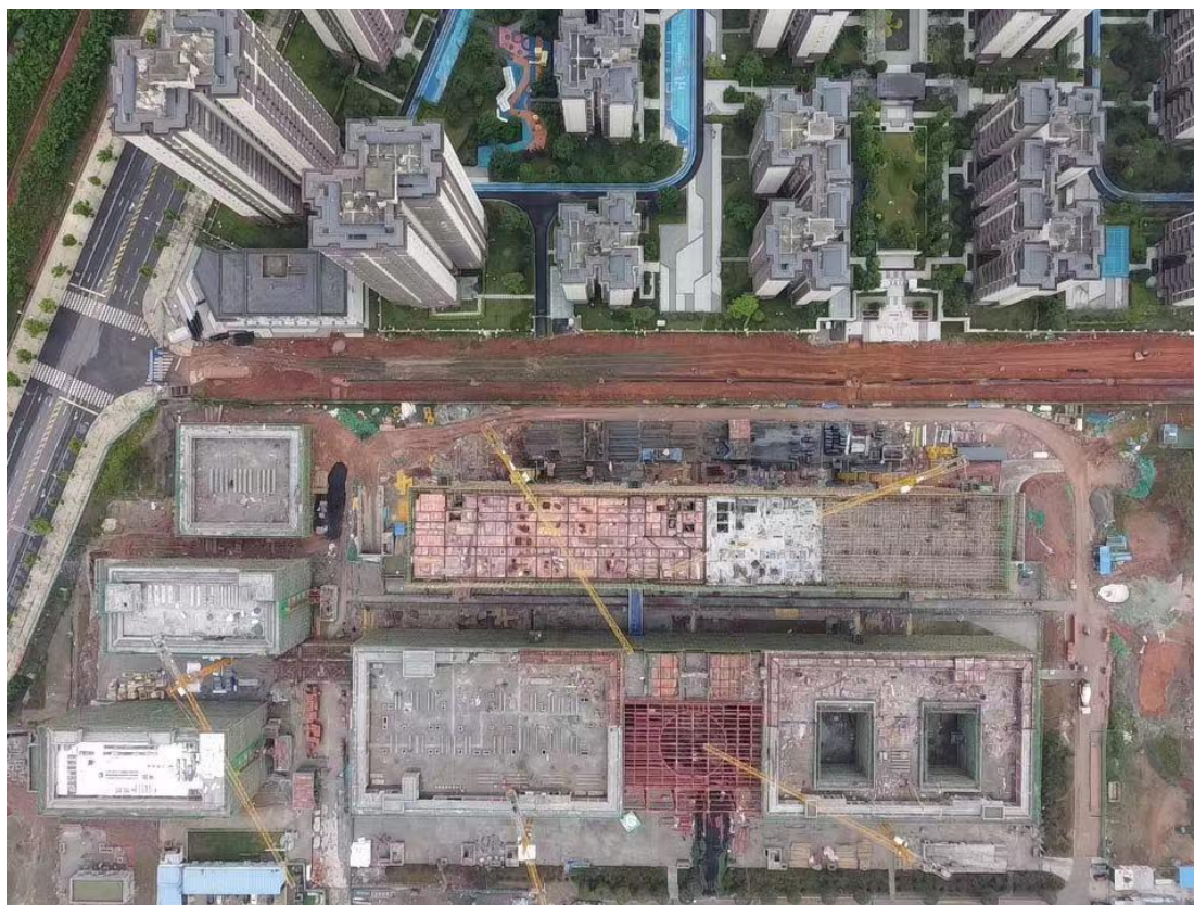
新院区建设现场航拍图（1）
